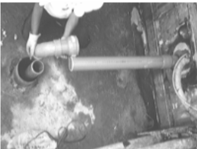
写真 - 4 100VP曲管部接合作業
