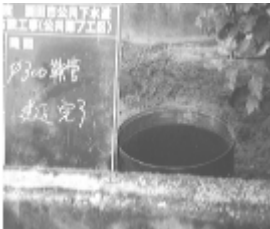
写真 - 1 300SGP鉛直推進完了
