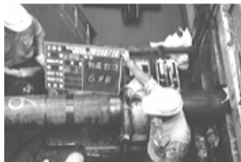
写真 - 2 水路下越し 300SGP推進作業
